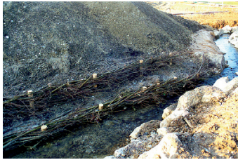
8 Verbauung des Bachufers mit Weidenflechtwerk.
