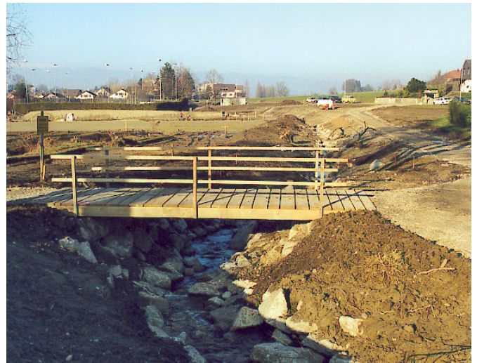
Eine von sechs Brücken, die über den Mühle- und Rugangbach führen.
