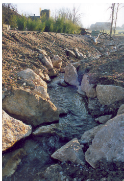
Bachverbauung mit Jurakalkstein
