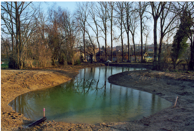
10 Rückhalteteich beim Mühlebach.
